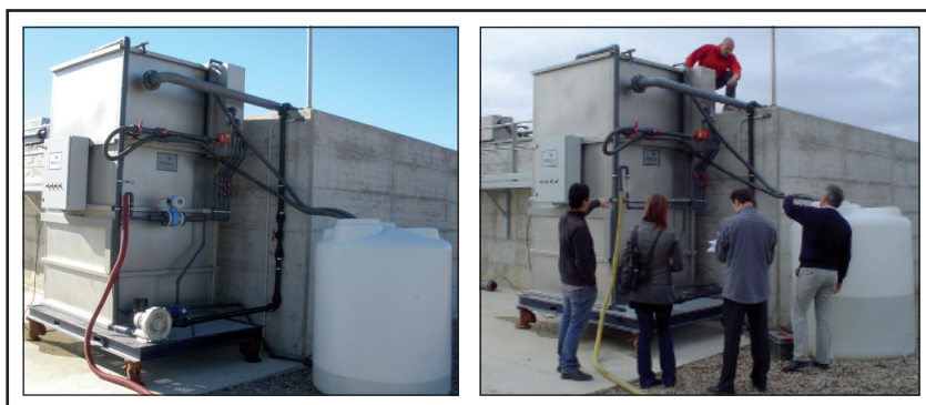
Figura 7. Puesta en marcha de la planta piloto a escala real.
