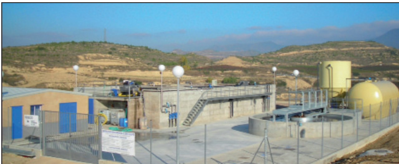
Figura 6. Vista general de la EDAR de San Vicente de la Sonsierra.
